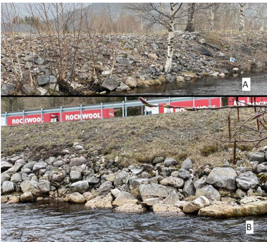
Figur 5: Bildene viser en bit av stasjon 1A (bilde A) og en del av stasjon 4B (bilde B). Egne bilder fra 25.04.2024.
