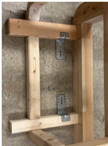
Figur 31 - Bilder: stabilisering av bein
