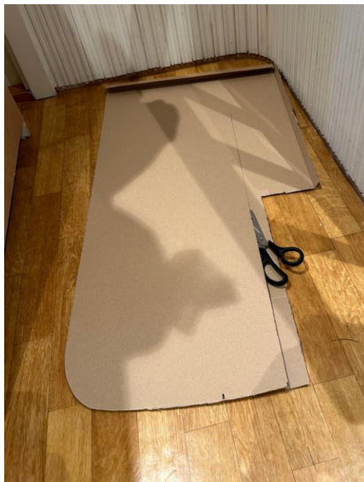
Figur 17 – Bilde: tilpassing av pappbit
