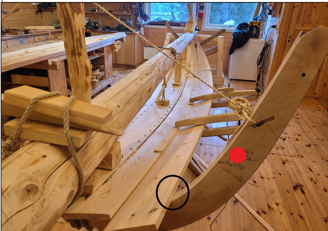
Fig. 30. Ved andre bordgang ble samme prosedyre gjentatt; bordet ble lagt opp i støttespantene og festet først på midten og deretter ut mot endene. Det leddete støttespantet (rød prikk) ble strammet opp slik at bordet fikk rett høyde og legg. Overkanten av bordet lå i mot støttespantet (svart sirkel). På undersiden og i nedkanten av bordet ble det presset opp med en kile (ikke synlig på bildet).
