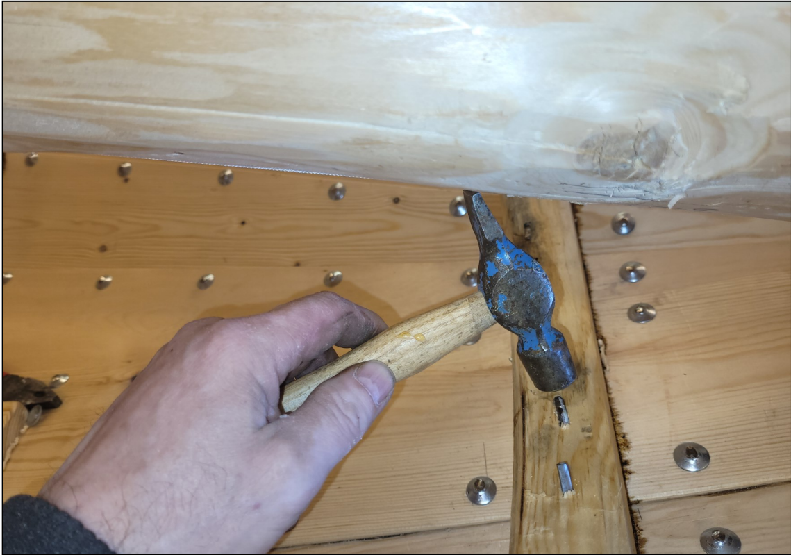
Fig. 41. Frambandet ble festet med nøkket spiker der hvor det var minst plass under byggestokken.
