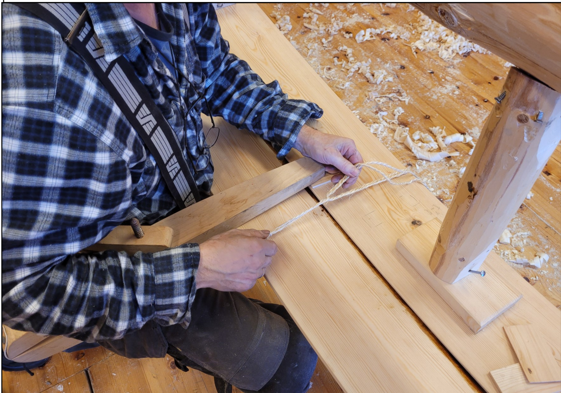
Fig. 26. Med en hyssingstump ble bordet holdt på plass inntil alle klemmene var festet. Med innfesting fra midten og ut mot hver ende av båten viste det seg at dette var nødvendig. Tilsvarende surring ble brukt til og med tredje bordgang.
