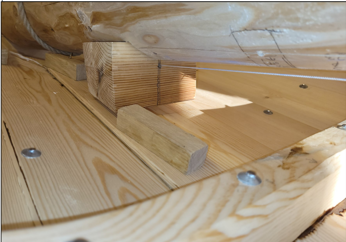
Fig. 42. Med tredje bordgang på plass hadde hampetauet som holdt båten oppe blitt strukket over 1 cm. Det var ikke bare tyngden av båten som strakk tauet, men også motspennet i de 7 bordene. En vidje ville trolig motstått strekket langt bedre enn hampetau.
