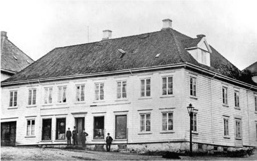
Henrik Ibsen vart fødd i Stockmanngården i Skien. «Denne bygningen lå,» skriv Ibsen, «lige imod kirkens forside med den høje trappe og det anselige tårn. Til højre for kirken stod byens gabestok og til venstre lå rådstuen med arrestrum og 'dårekisten'.» Bygarden, som har namnet sitt etter kjøpmann Christian Paus Stockmann, brann ned til grunnen ved den store bybrannen i Skien (1886). Foto: Fotograf ukjend / Telemark Museum
