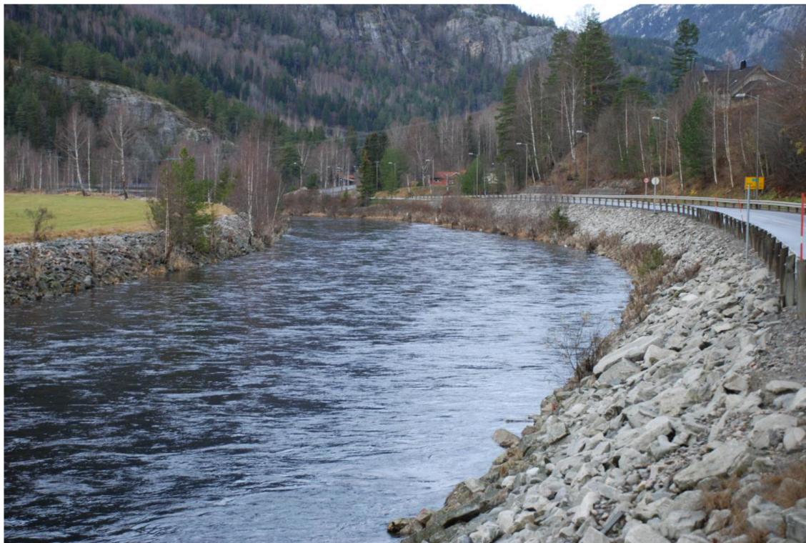
Figur 4.1. Bilde tatt fra den østre elvebredden som viser plastring i forbindelse med E134 (Kraabøl 2016).
