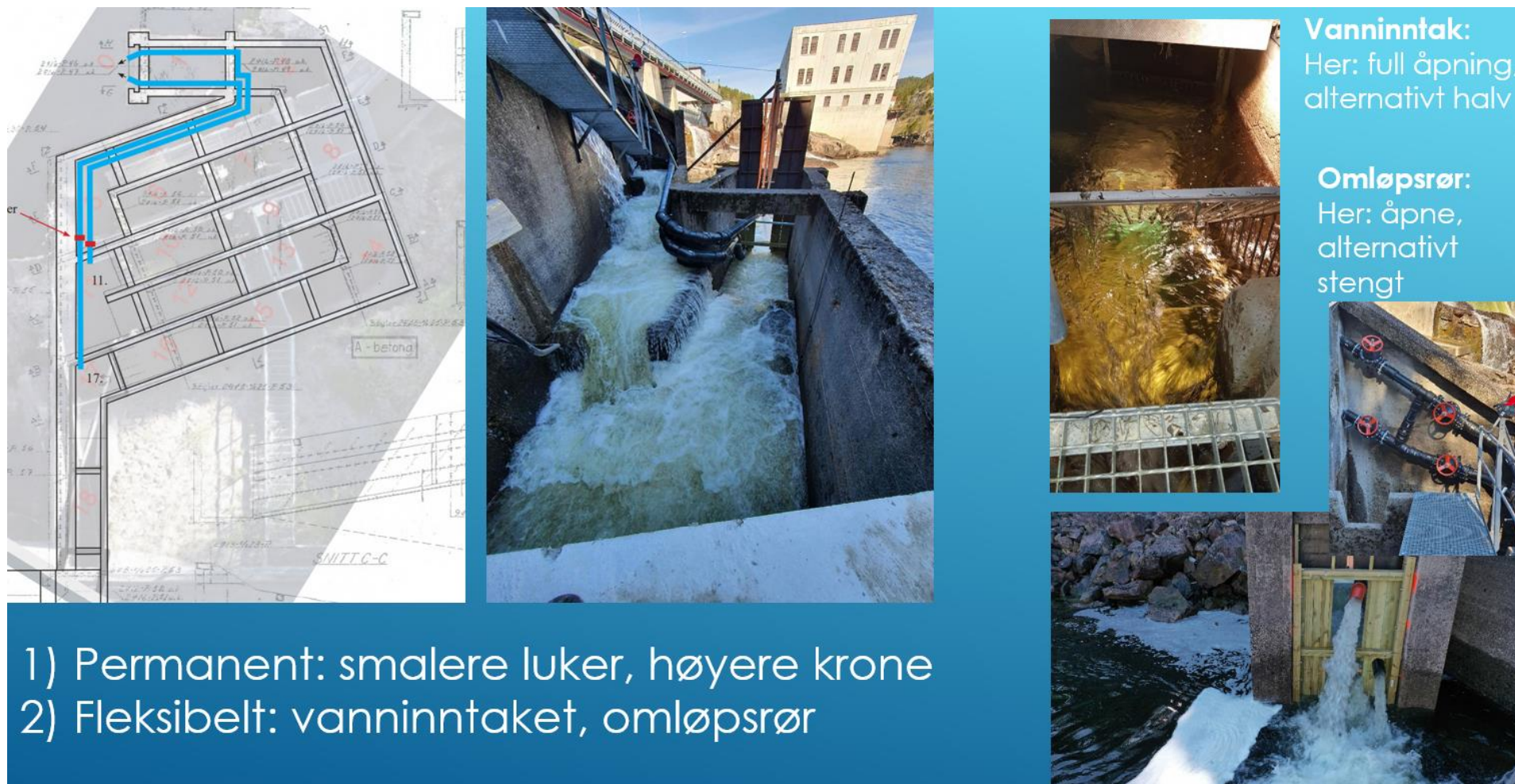
Figur 20. Ved ombygging av fisketrappen i Skotfoss våren 2021, ble spalteåpningene i de to nederste kulpene gjort smalere og terskel litt høyere for å redusere energitettheten. Samtidig ble det lagt inn to omløpsrør som tok ut vann fra hhv. kulp 11 og 17 (venstre bilde, røde punkter) og dermed reduserte vannføringen i nedre del av trappa. Dette vannet ble ført til inngangen og brukt som lokkevann (høyre bilde).
