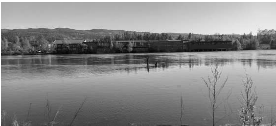
Figur 10 Drammenselva mot Steinberg, Gamle Eker Pairfabrikk
