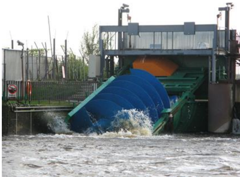
Figur 7: Bilde av en arkimedesskrue i drift [12]
