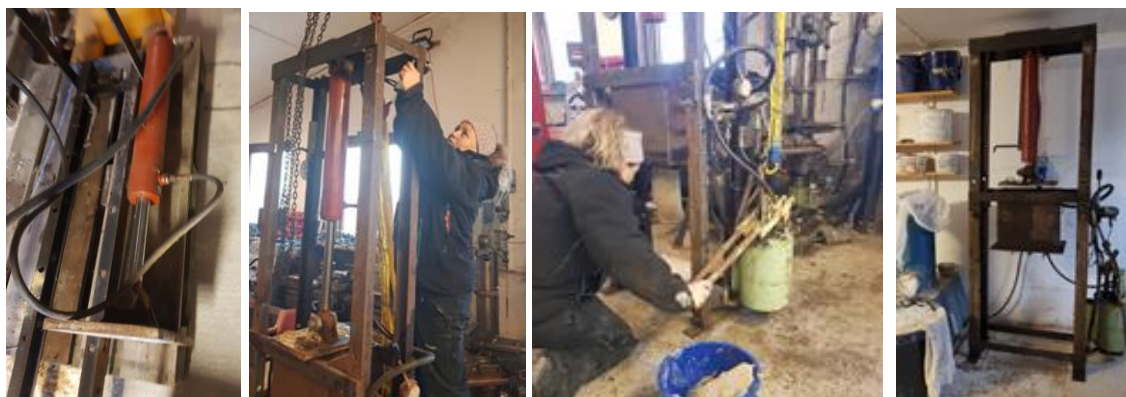
Figur 62: Hydraulikkstempel med påsveiset plate i enden. Figur 63: Viser montering i ramme. Figur 64: viser den manuelle pumpen. Figur 65: Viser den ferdige ekstruderen på plass i mitt verksted.
