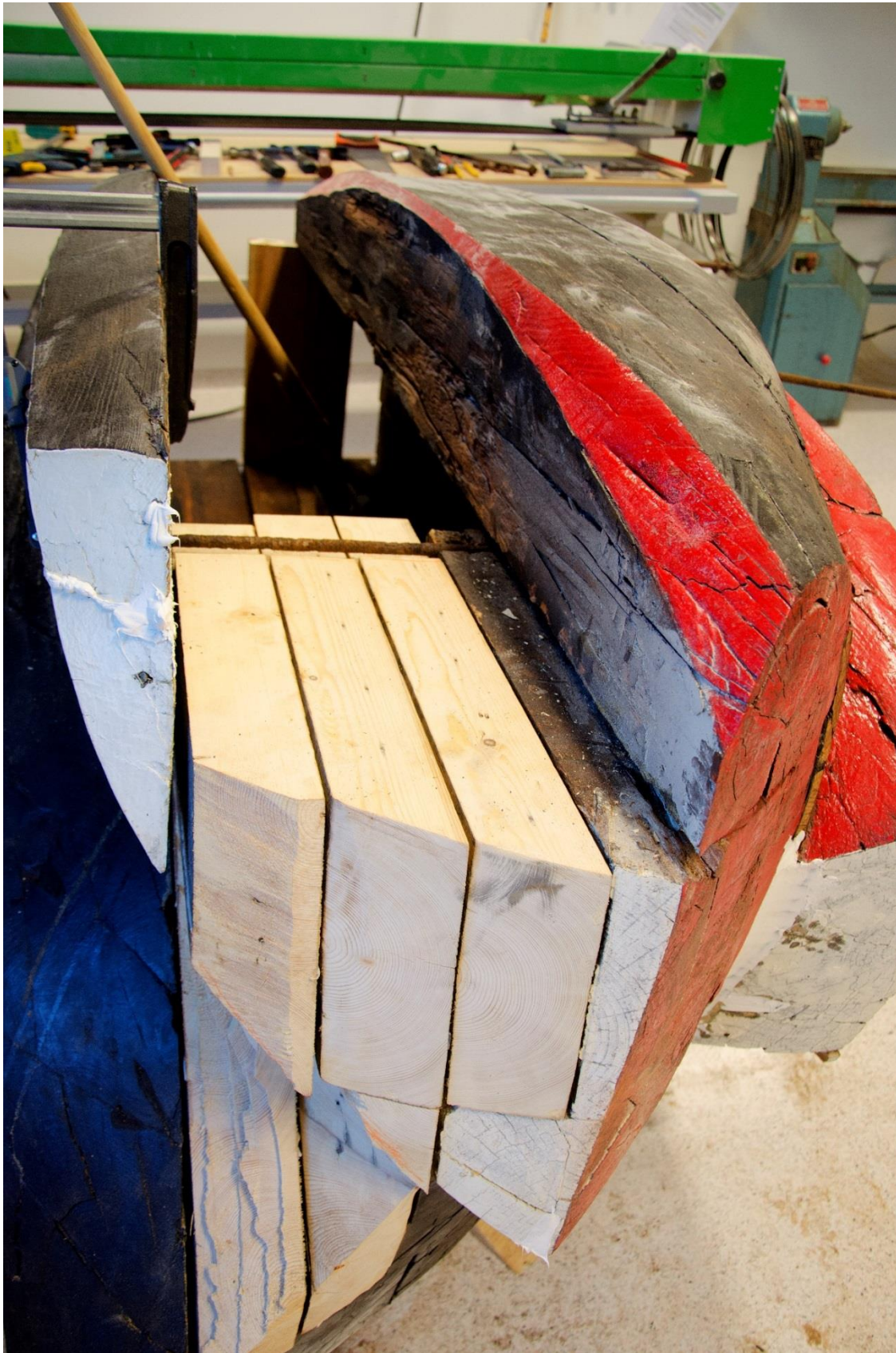
Illustrasjon 9: Bildet viser innsetting og tilpasning av nytt trevirke i toppen av skulpturen. Det synes også at den gamle toppen har vært reparert ved å spikres sammen, noe som har gitt sprekker i veden. Det ble fuget igjen med hvit Tec7.
