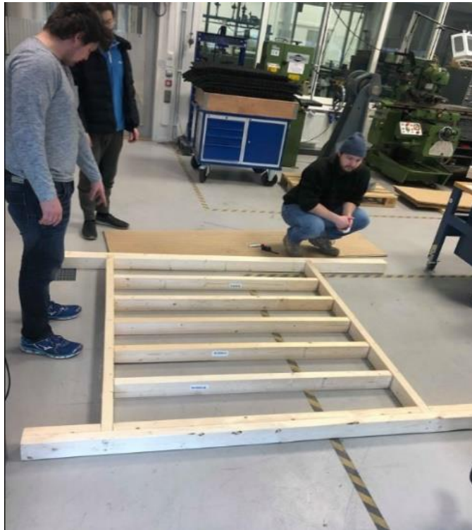
Vedlegg Figur 54: Snekring av «hovedvegg»
