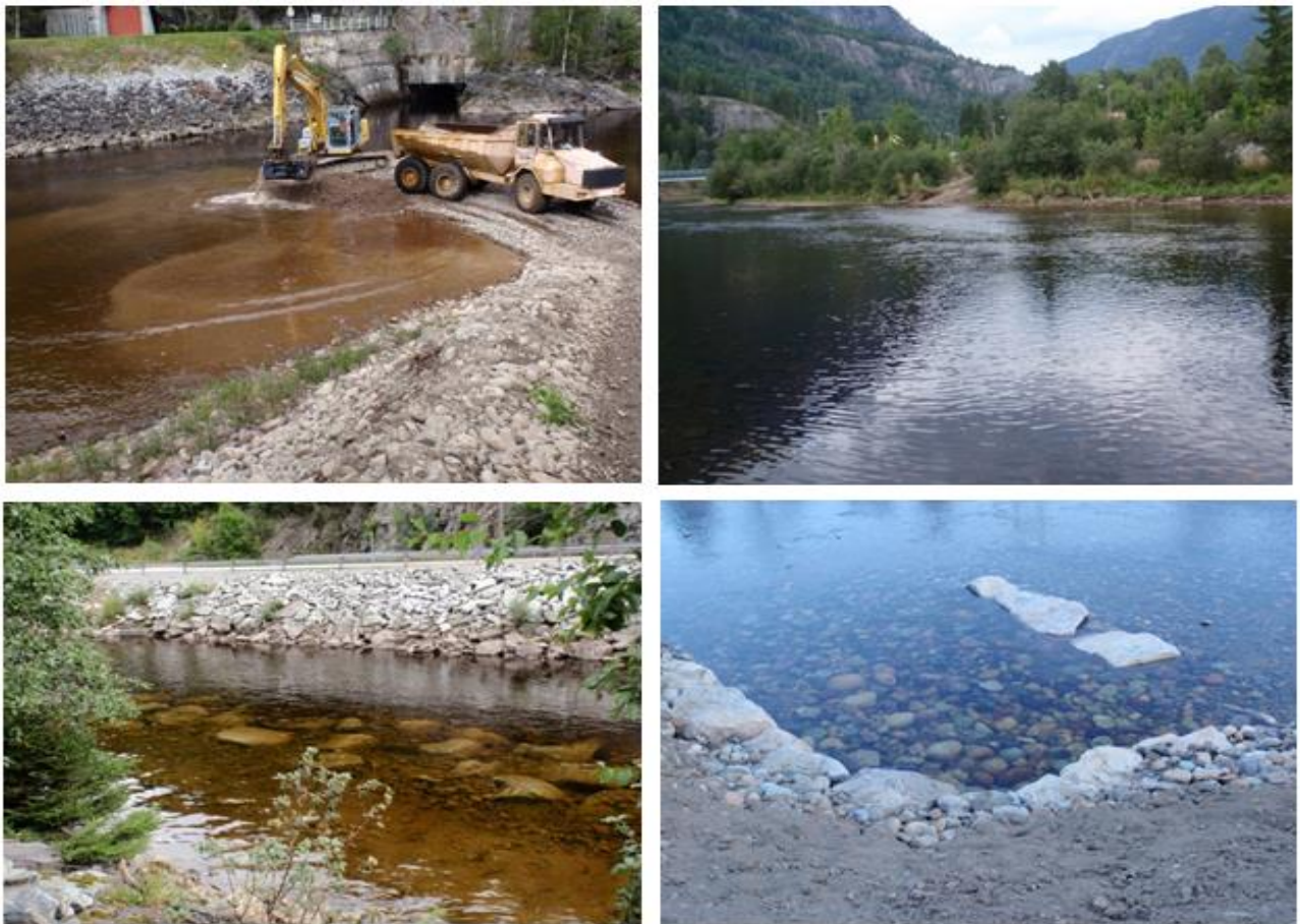
Figur 2.4. Øverst til venstre; senkning av grusøyren utenfor avløpstunnelen til kraftstasjonen, øverst til høyre; senkning av elvekantareal nedstrøms bro til kraftverket med ca. 20 cm, nederst til venstre; steinsetting i elva langs E134, nederst til høyre; etablering av kile ved stasjon 5 (Kildal 2012, Kildal 2013).
