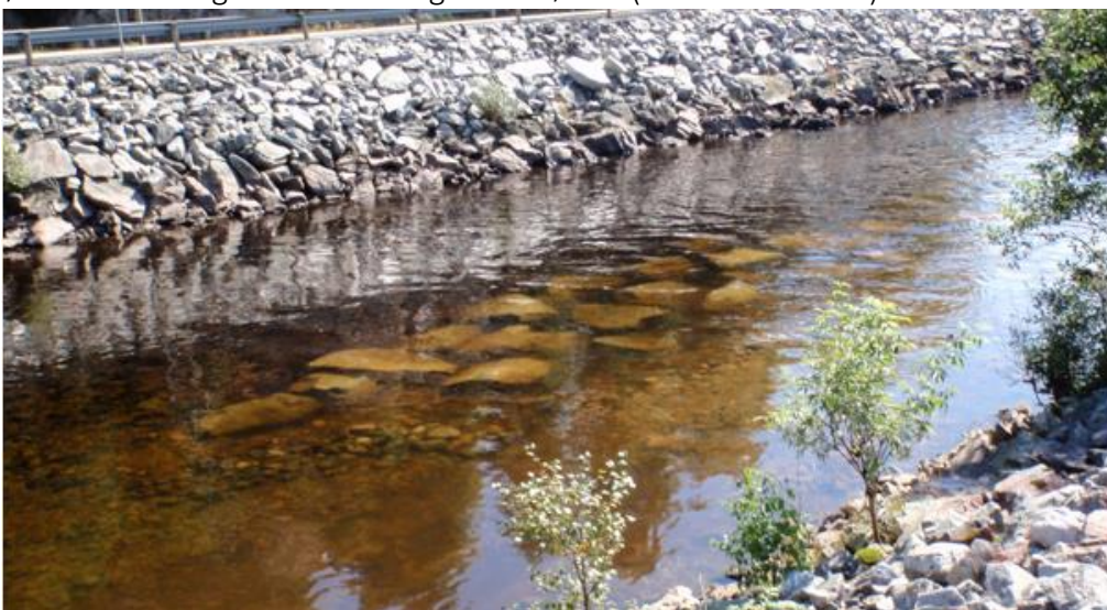
Figur 4.2. Steinsetting i Vallaråi langs E134 i tilknytning elektrofiskestasjon 4. Denne strekningen ble forbygd med bratte, rette og grovsteinede elvekanter i 1985 (Kildal 2012).
