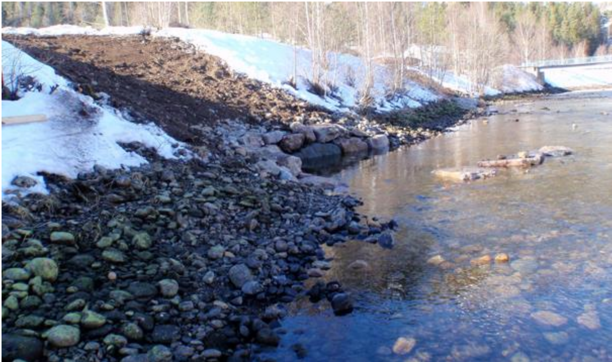
Figur 2.6. Etablering av kile med grovsteinede buner på elektrofiskestasjon 5 i Vallaråi. Selve kilen er bygd av grove steiner, og bunene utenfor styrer vannstrømmene inn i kilen (Kildal 2013).
