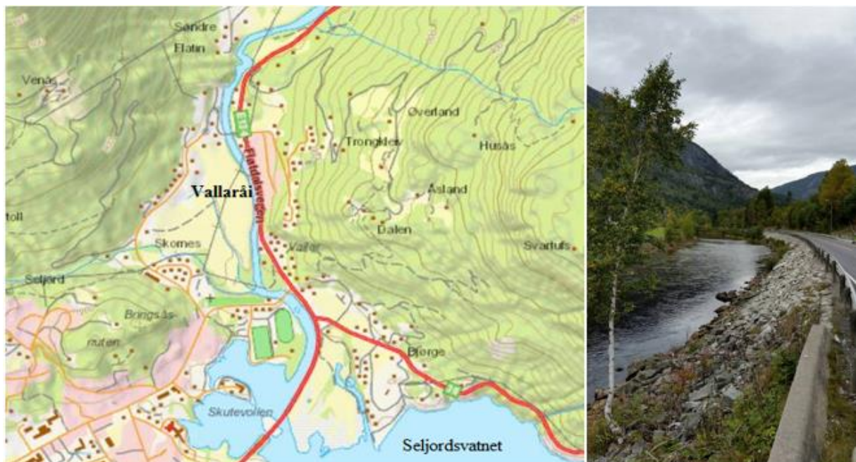
Figur 2.3. Vallaråi og Seljordsvatnet med E134 angitt som rød linje (til venstre) (NVE Atlas). Plastring av elvebredden i forbindelse med utbedring og omlegging av E134 (til høyre).
