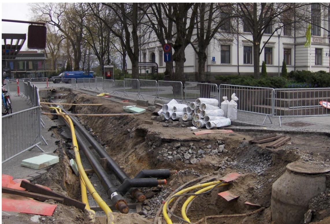
Foto: Skagerak Energi. Legging av fjernvarmerør i Porsgrunn.
