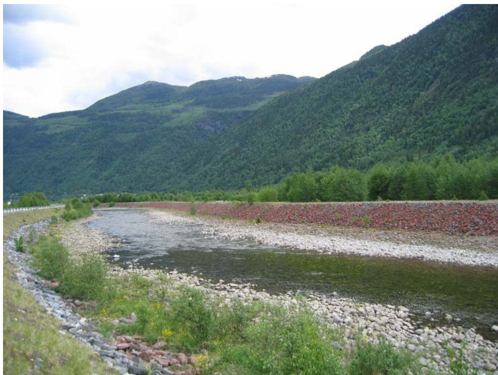
Fig. 2. På nedre del av Måna er lange elvestrekninger kanalisert.
