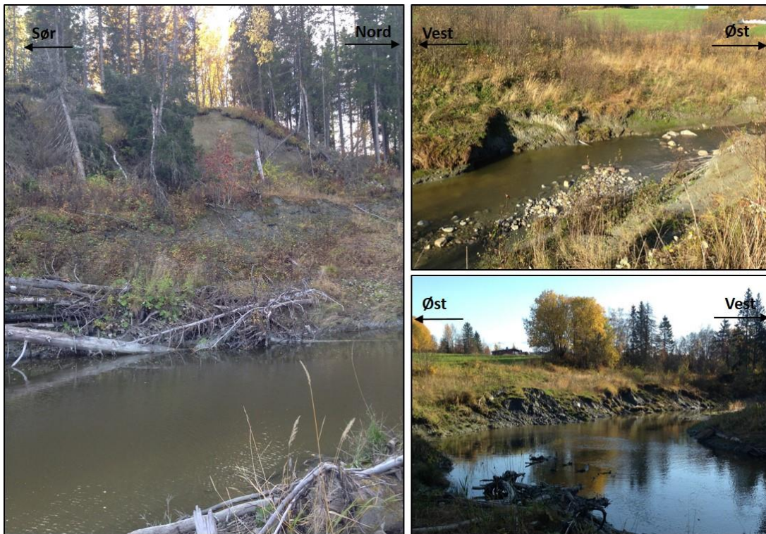
Figur 9-23 Til venstre: en større utglidning langs elva. Til høyre: mindre utglidninger flere steder langs elva. Foto: B. Gundersen 2014.
