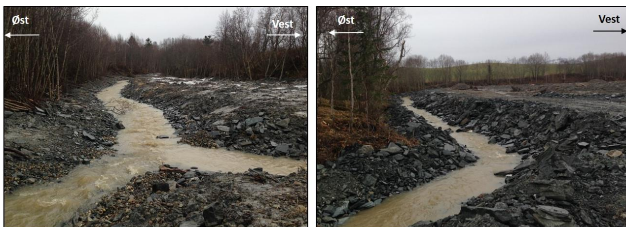
Figur 6-6 Bilder av sikringen av den resterende delen av Ristbekken som renner gjennom skredmassene (fig. 9-2). Foto: B. Gundersen 2015.
