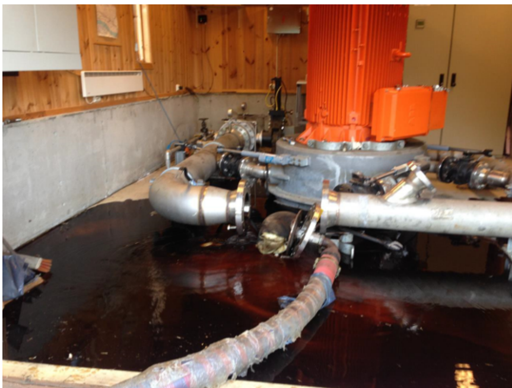
Figur 2: Proppen har kommet ut av rørgaten
