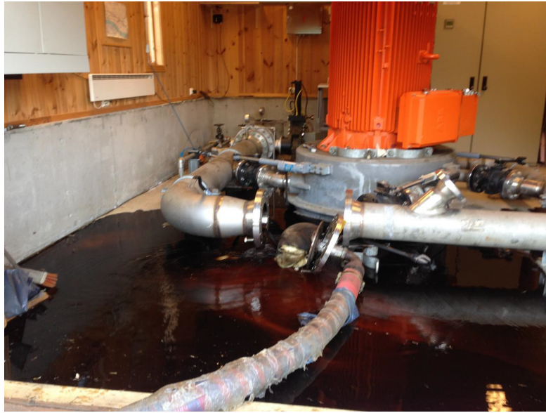
Figur 2: Demontering av utstyr etter proppkjøring
