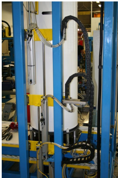
Figur 77 Ferdig monterte kabelkjeder.
