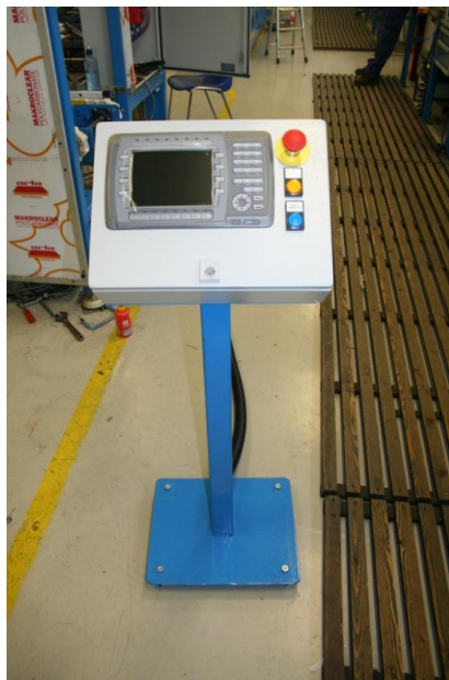
Figur 79 Skap montert på fot. Inngående ledninger lagt i plastrør.
