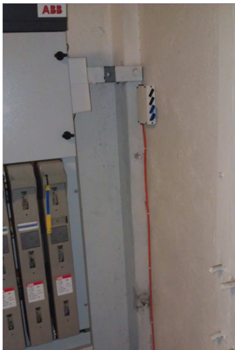
Bilde 4 Fiber ferdig terminert
