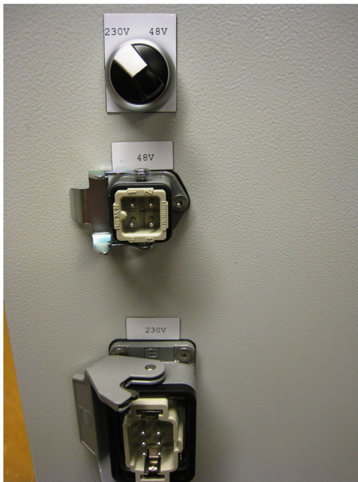
Bilde 3 Vri Bryter for alternering mellom 230V og 48V
