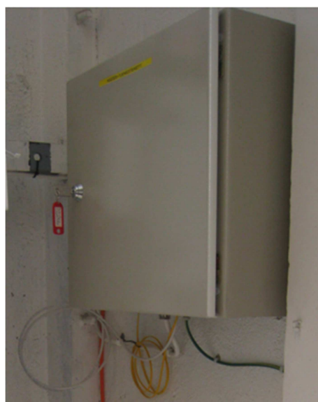
Bilde 7 Ferdig montert skap
