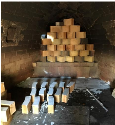
Bilde 6-Fyringsmesters tørrmurte vegg bak i ovnen
