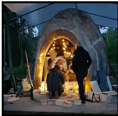
Bilde 1- Foto av deltakere som tørrmurer ovnsdøra midt på natten i 2020. Tatt av Lillann Ulverud
