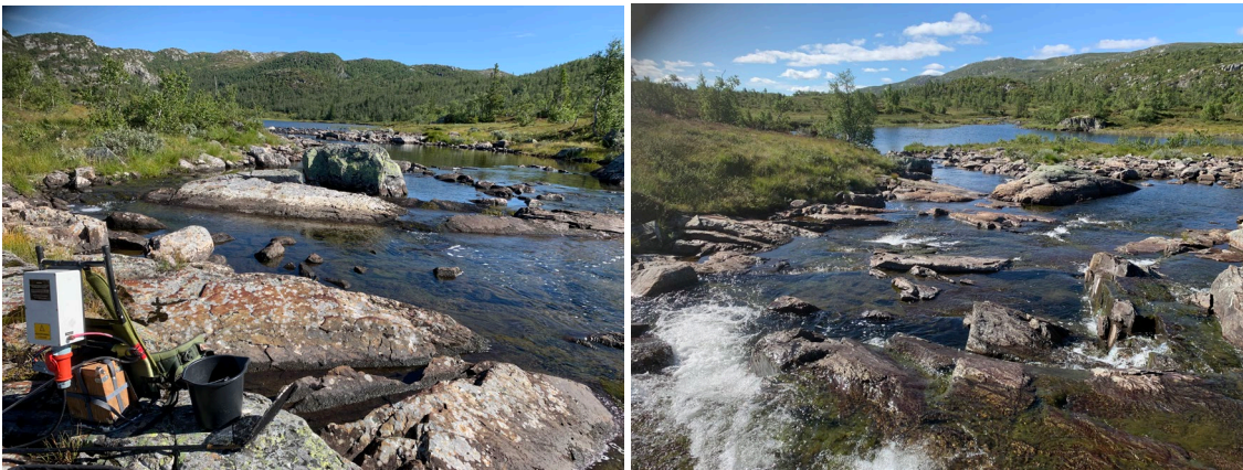
Figur 31. Kova på utløpet fra Bjønntjønn, oppstrøms (venstre) og nedstrøms fjellsva (høyre).
