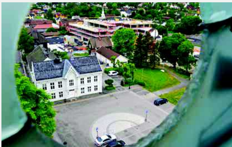
Krona under bygging! Bilde er tatt gjennom urskiva i klokketårnet i Kongsberg kirke i juni 2014. (Søker du opp «Krona blir til» i YouTube kan du se hele byggeprosessen på under tre minutter).
