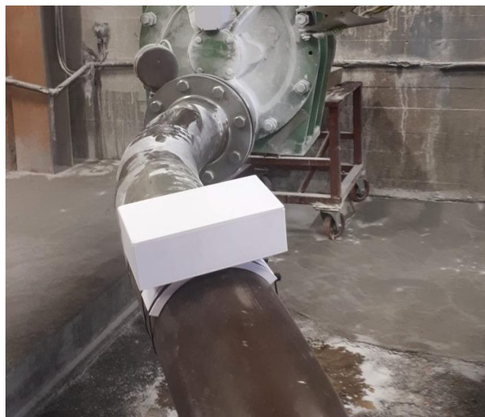
Figur 2-19 - Feste på rør med strips
