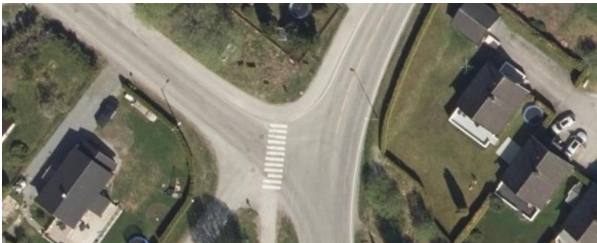
Figur 4.9 Bilde fra Norge i Bilder viser T-kryss på fylkesvei 3290 [2]
