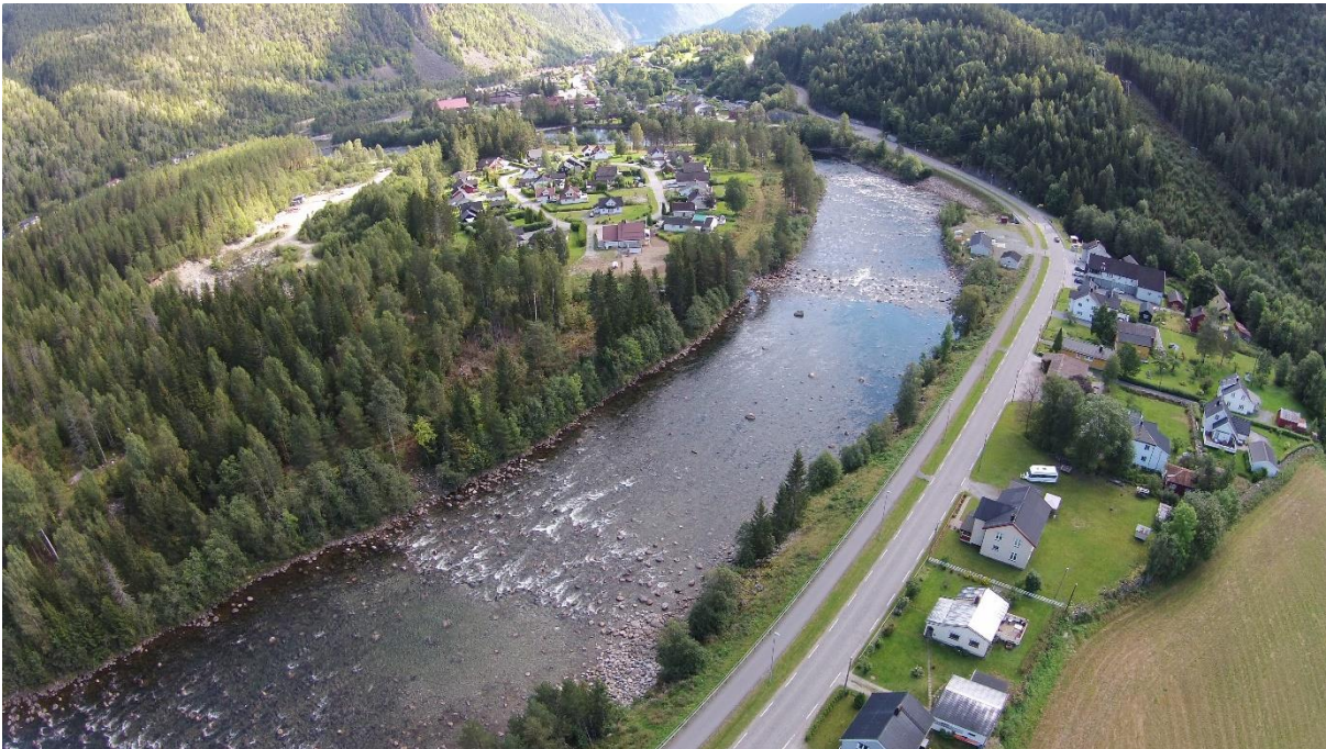
Figur 2. Eksempler på fysiske tiltak i Tokkeåi. Øverst: Utlagt blokk oppstrøms Geishyl. Midten: Gravearbeider nedstrøms Geishyl med utlegging av stor blokk. Nederst: Ombygde terskler 1 og 2 med et utjevnet brekk/fall og mer strykhabitat. Foto: Statkraft.
