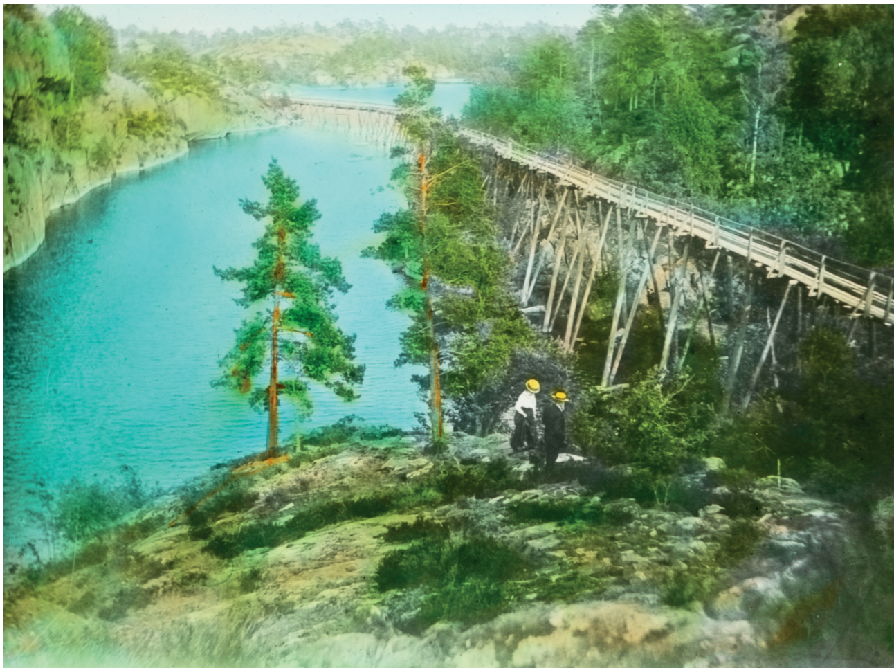
Figur 7. Til eksportanleggene for is hørte mange steder lange isrenner for å transportere isen fra dammene til ishusene og utskipingsstedene, som illustrert på dette håndkolorerte fotografiet fra Stabbested ved Kragerø. I beste fall er fundamentene til disse imponerende anleggene bevart i terrenget til våre dager. Foto: Johan Lyng Olsen. Tilhører Telemark Museum.
