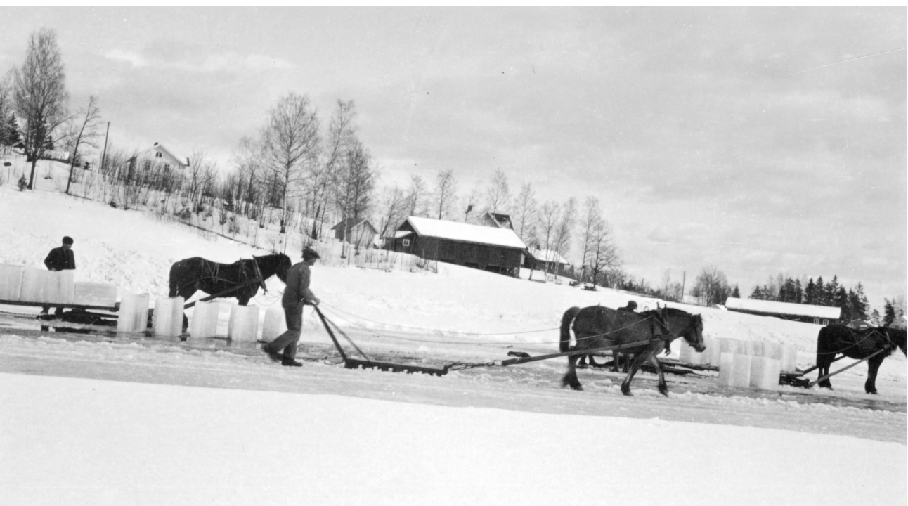
Figur 1. Grovskjæringen av isen og mye av frakten skjedde med hestekraft, som her på isanlegget i Lagdalen ved Leangbukta i Asker i 1925. Dette skal være det første stedet hvor det ble anlagt kunstig dam til isproduksjon ved Indre Oslofjord. Ukjent fotograf. Tilhører Norsk Maritimt Museums fotoarkiv (NSM 3000-046).
