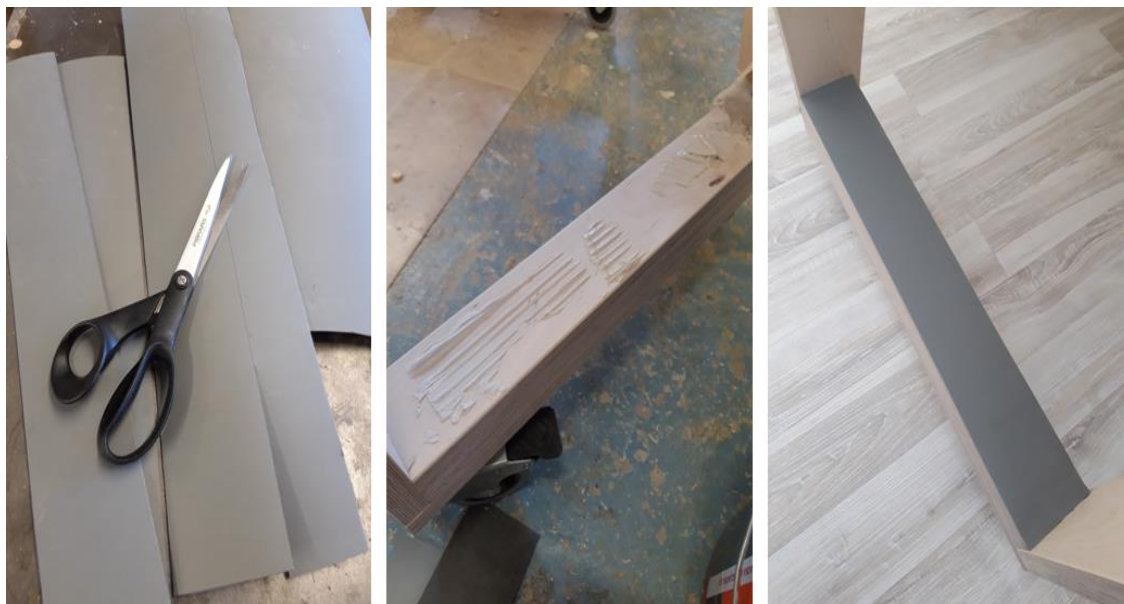
Figur 60. Arbeidsprosessen med å lime på linoleum på beinstøtten på modul to.
