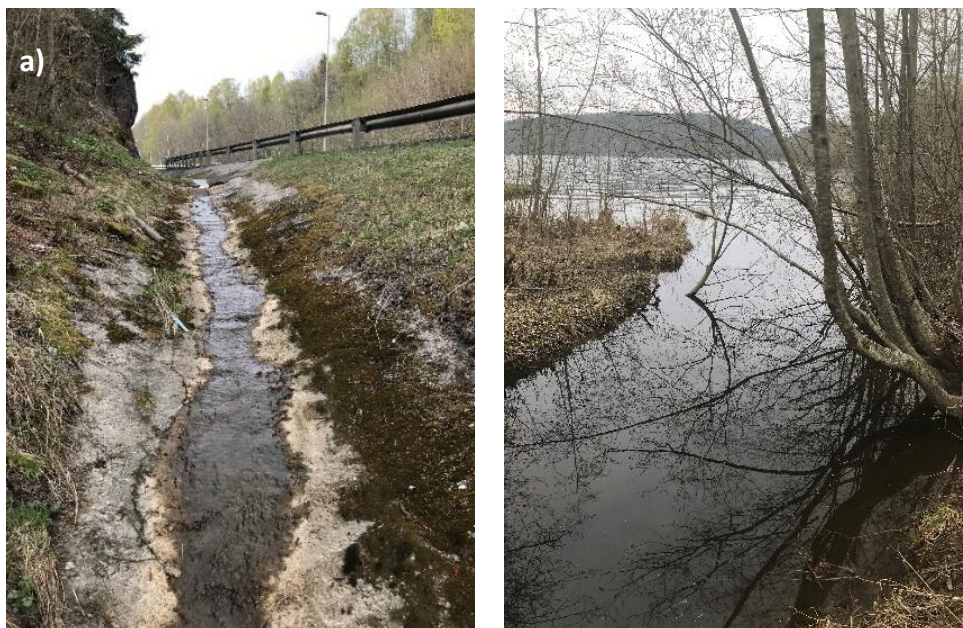
Figur 2.4: a) asfaltrenna langs Hanesbakken b) utløpet til Audnabekken ved Hanesbukta (fotograf: Lene Roughvedt)
