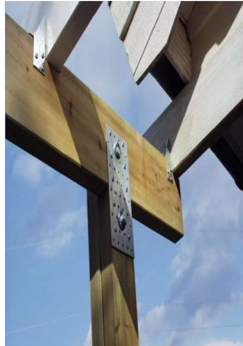
Figur 107: Horisontal bjelke med en last holdes oppe av en vertikal bjelke [53]
