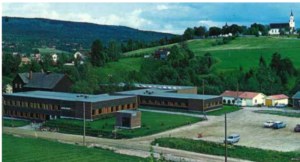
Frivoll. Bygget stod ferdig til haustsemesteret 1971. Folkets Hus i bakgrunnen til venstre.
