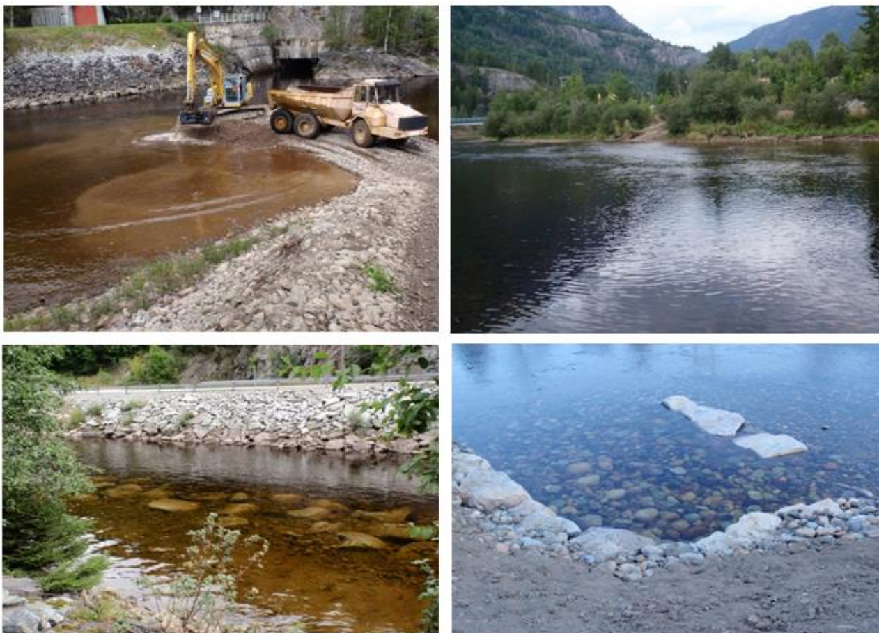
Figur 2.4. Øverst til venstre; senkning av grusøyren utenfor avløpstunnelen til kraftstasjonen, øverst til høyre; senkning av elvekantareal nedstrøms bro til kraftverket med ca. 20 cm, nederst til venstre; steinsetting i elva langs E134, nederst til høyre; etablering av kile ved stasjon 5 (fra Kildal 2012; Kildal 2013).
