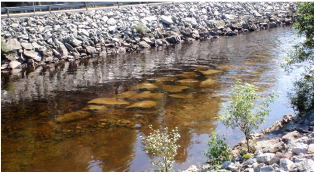
Figur 5.2. Steinsetting i Vallaråi langs E134 i tilknytning elektrofiskestasjon 4. Denne strekningen ble forbygd med bratte, rette og grovsteinede elvekanter i 1985 (Kildal 2012).
