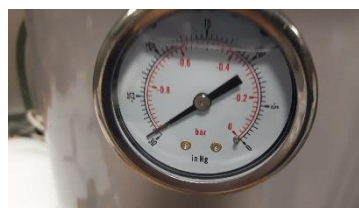
Etablering av undertrykk
