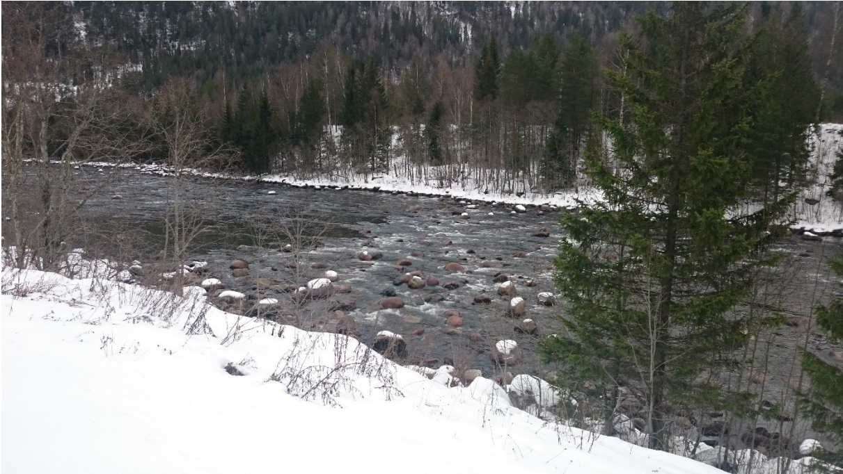
Figur 7. Terskel 1 (bildet) og terskel 2 er ombygd i 2016 for å skape en jevnere gradient med mer habitat. I begge tersklene er det gytesubstrat, men i relativt grovt i terskel 1.
