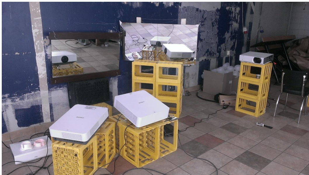
Figur 26 Teknikken på innsiden
