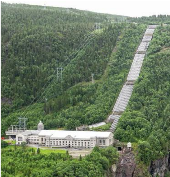
Figur 31. Rørgaten i tilknytning til Vemork kraftstasjon. Foto: Trond Taugbøl. (Taugbøl et al., 2014).
