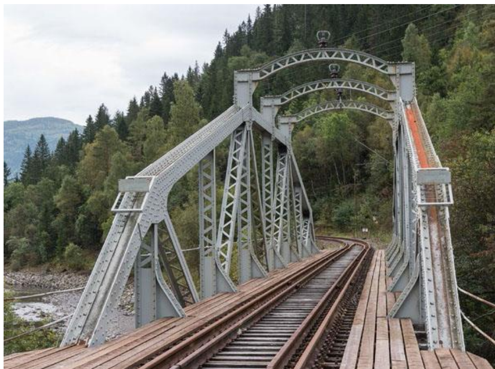
Figur 34. Jernbanebru med klinkede metallnagler, Miland bru på Rjukanbanen. Foto: Per Berntsen (Taugbøl et al., 2014).
