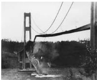
Bilde 13 : Eksempel på ukontrollert resonans: Tacoma Narrows Bridge, USA, 1940 (Halmrast, 2013, s. 32)
