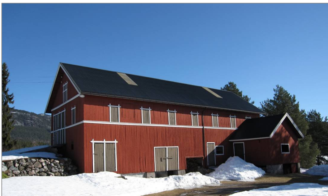
Låven på Norheim med den tilbygde stallen ut mot tunet.. Foto: Solveig Svardal.
