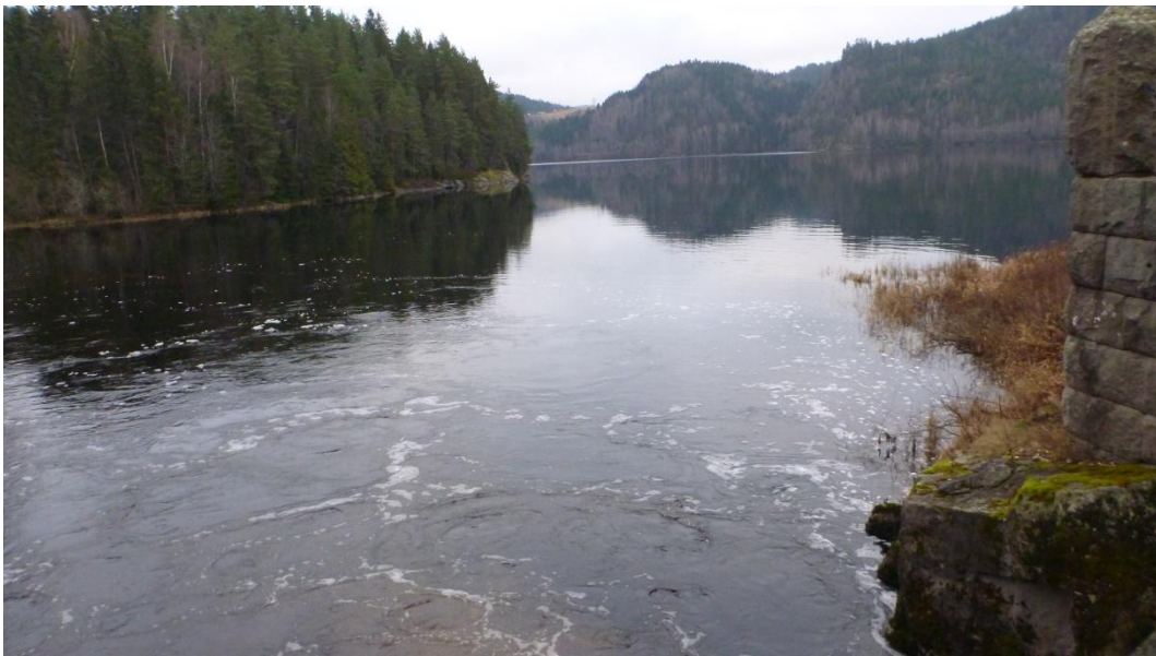
Figur 7. Undervann fra Kiste kraftstasjon går direkte i Lakssjø og bestemmer vannføringen videre nedstrøms.
