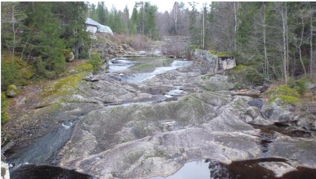
Figur 12. Kistefoss er tørrlagt og vil kreve betydelige tekniske tiltak for at laks skal kunne vandre videre opp i vassdraget.
