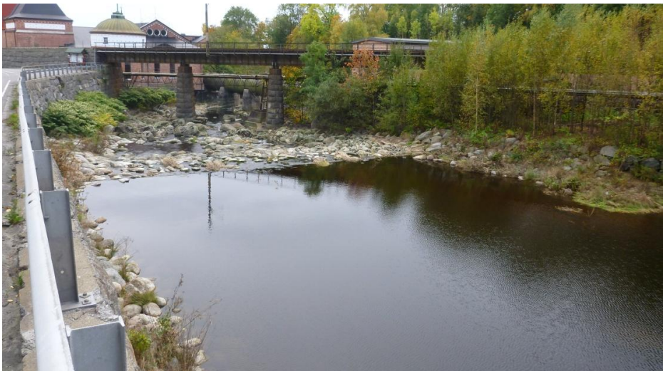
Figur 5. Terskler gir vannspeil fra utløp Farris til sjøen (Hammerdalen): 1-2. første og andre terskel og bassenger, mellomliggende 200 m lang tørrlagt strekning, 4. tredje terskel og basseng, og 5. fjerde og nederste terskel før elva renner ut i sjøen.
