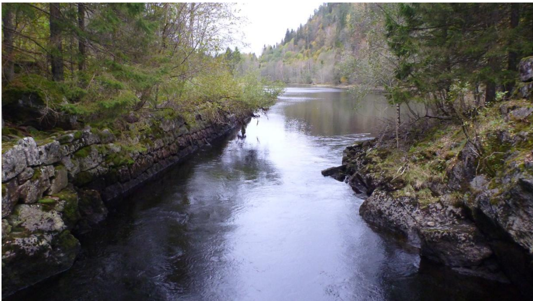
Figur 10. Merkedammen ble bygget 1915 som erstatning for Lakssjødammen som forsynte jernverket med vann. I den forbindelse ble også kortere tilliggende elvestrekning forbygd.
