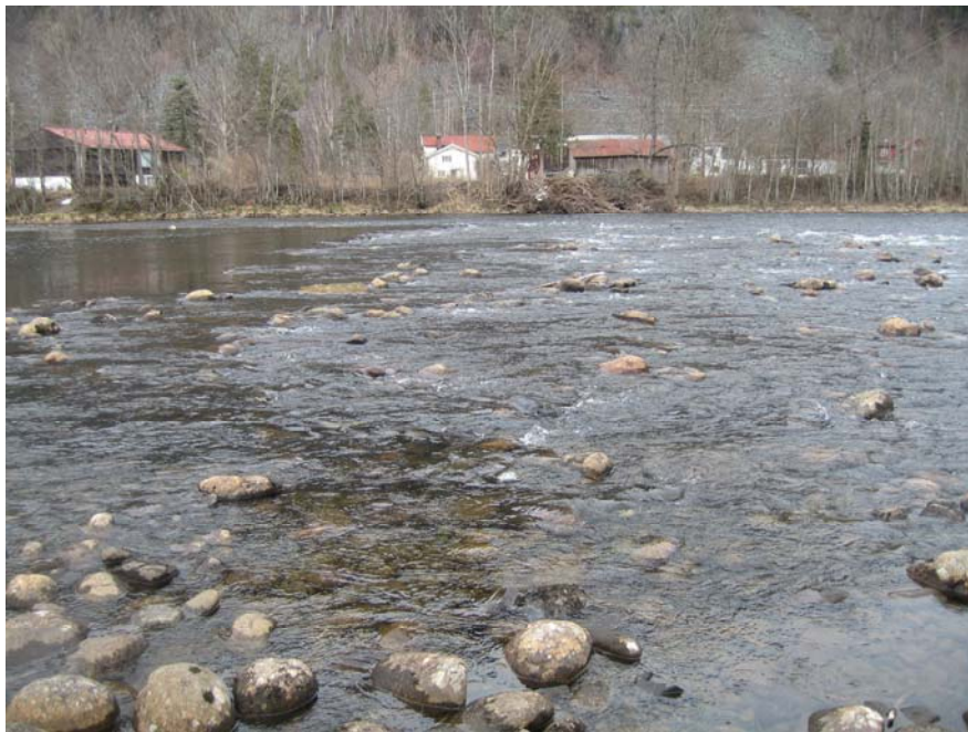
Figur 50. Bredt og grunt overløp ved terskel nedstrøms Fredheim.
