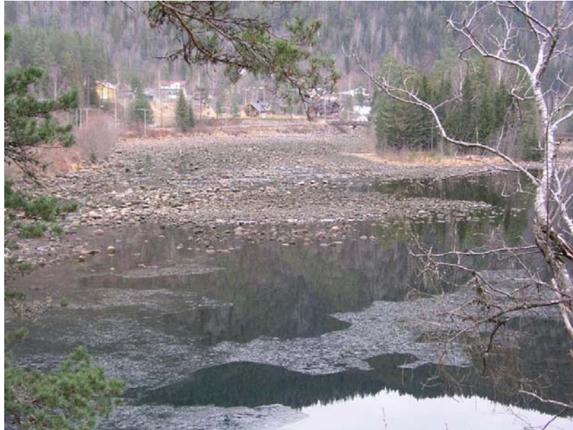
Figur 38. Terskler på ut Huvestadhylen på normal lavvannføring (ca. 14\text{m}^3\text{s}^{-1} ) og ekstrem lavvannføring ( 2\text{-}3\text{m}^3\text{s}^{-1} ).
