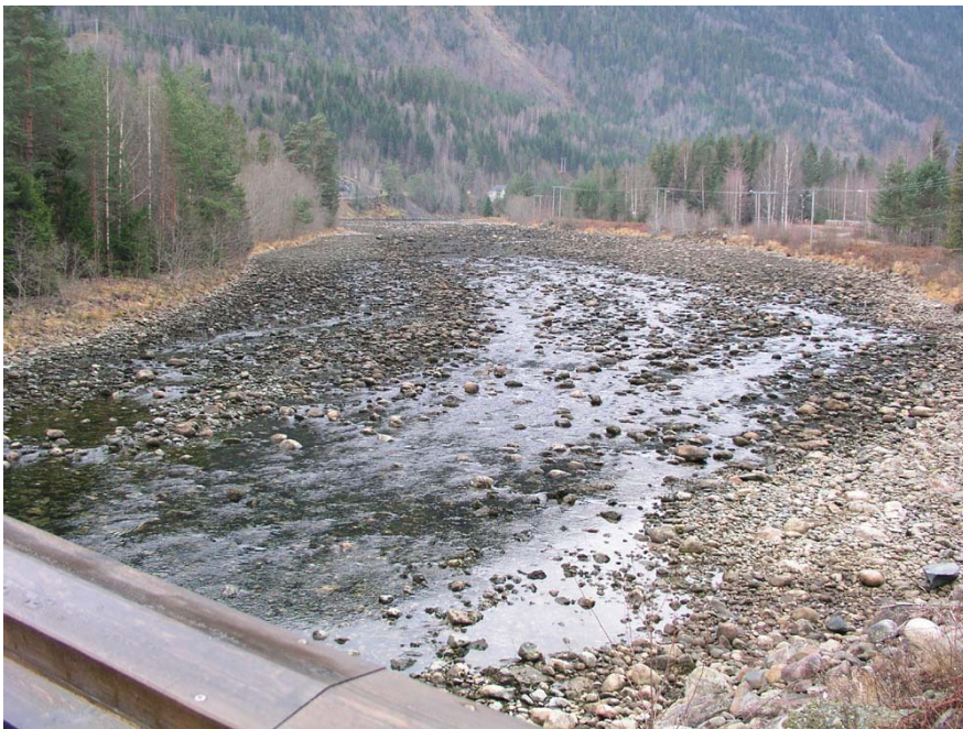
Figur 39. Tokkeåi østre løp sett oppstrøms mot terskel på utløp Huvestadhylen på normal lavvannføring (ca. 14\text{m}^3\text{s}^{-1} ) og ekstrem lavvannføring ( 2\text{-}3\text{m}^3\text{s}^{-1} ).
