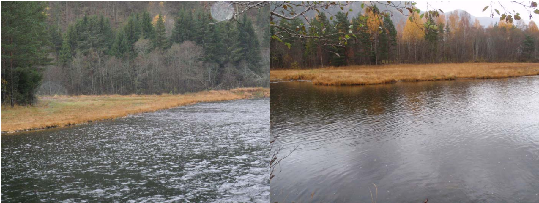
Fig. 20. Lave "elvfot" terskler bygd langs Tokkeelva ved Buøy.
