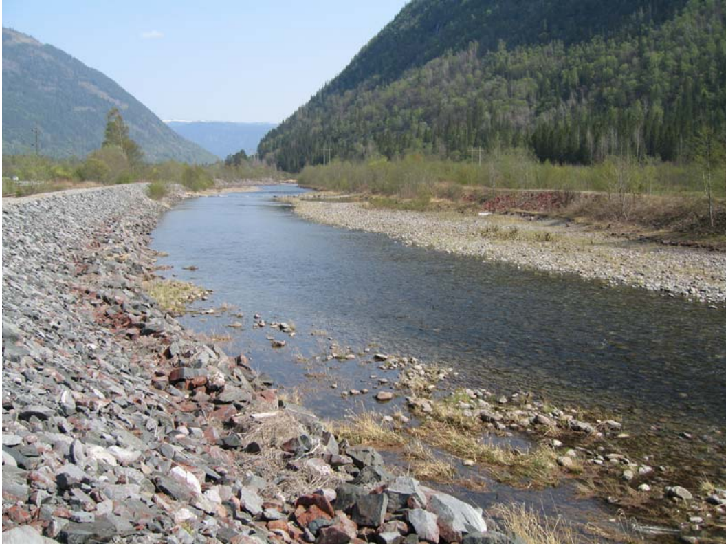
Figur 2. Kanalisert strekning av Måna nedstrøm Gaustå bru.
