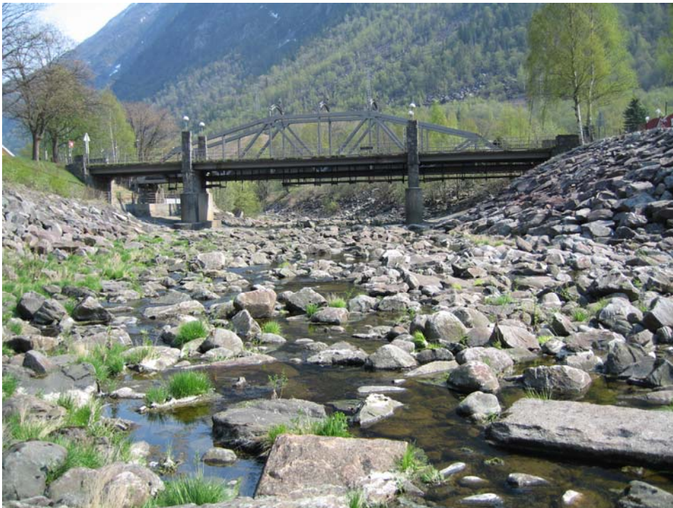
Figur 7. Inntaksdammen til Moflåt kraftstasjon (øverst) og veibru ved Rjukan kirke. Dammen er øvre og veibru nedre avgrensning for elvestrekningen ved Kirkesvingen.
