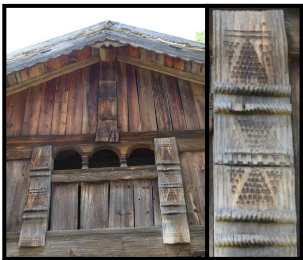
Figur 32-33: Loft fra Hol i Hallingdal fra ca 1650. Muruspjeld rundt lysåpningen i andre etasje. Norsk Folkemuseum. Foto: Birgit Wasrud
