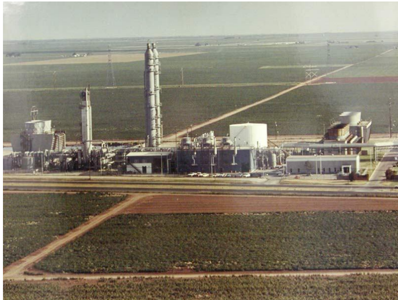
Figur 5. CO 2 -fjerningsanlegg i Garza Field ved Lubbock i Texas (Kilde: Wiley Inter Science)
