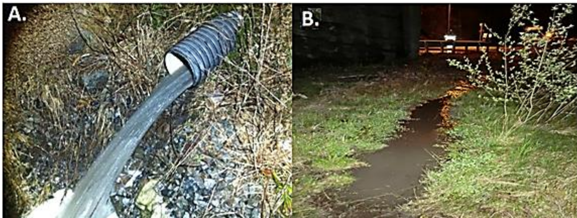
Figur 6. Utløpsrør for tunnelvaskevann til de prøvetatte tunnelene i Aust-Agder fylke. Steinsåstunnelen, bilde A. Tunnelvaskevann som renner i grøfta ned til Byglandsfjorden ved Fånefjelltunnelen, bilde B (Foto: Martin Stamland).
