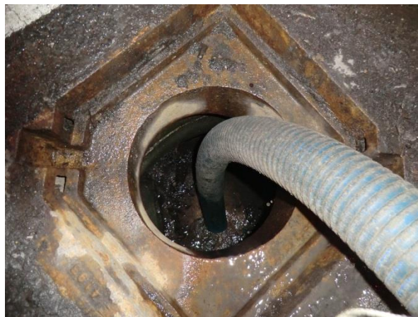
Figur 7. Et rør fra slamsugebil blir ledet ned i drenerøret og suger opp tunnelvaskevannet fortløpende under tunnvasken (Foto: Martin Stamland).
