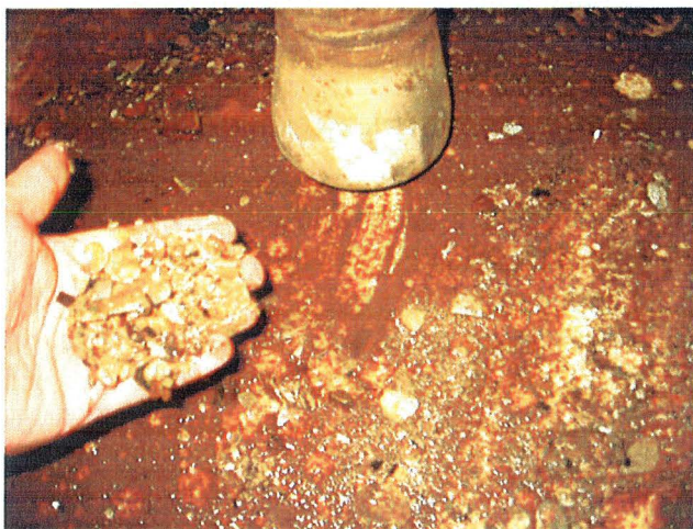
Figur 8.4: I urolig vær kan partikler og slam i drikkevannstanker bli virvlet opp og sugd inn i drikkevannsnettet, der de reduserer effekten av UV-anlegget (Foto: Bjørn Løfsgaard)
