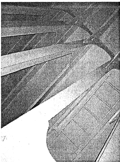
Figur 9.4: Bildet viser en nymalt tank. Det at tanken har stor veggflate i forhold til volumet øker risikoen for oppvekst av mikroorganismer og for at det skal oppstå problemer med lukt og smak etter maling (Foto: Eyvind Andersen)
