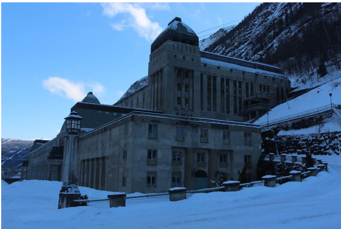
Foto: Privat. Tatt utenfor bygget og viser Saaheim kraftstasjon i sin helhet.
