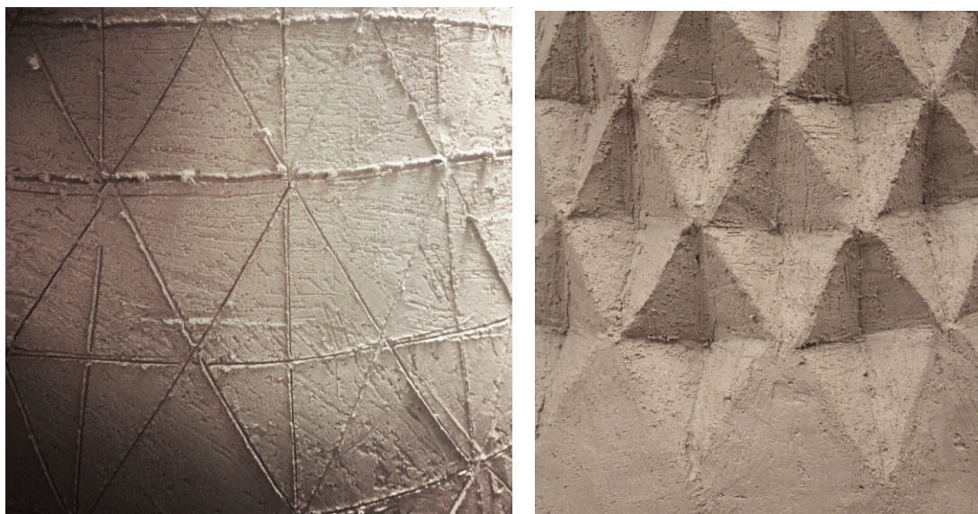
Figur 19: Skjæring av fasetter
