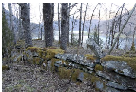
Figur 16 Mur med gjerde
