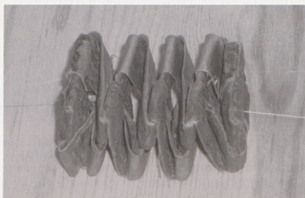
Bildet viser bastekæll lagd i 1986.
