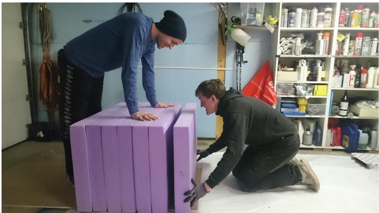
Figur 2 - Liming av polystyrenplater
