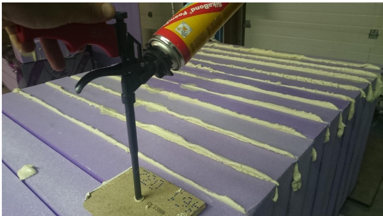
Figur 7 - Påføring av polyuretanskum
