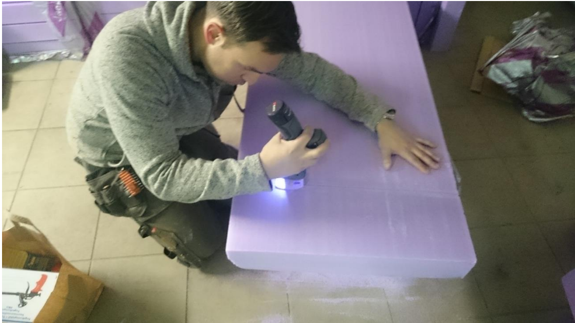
Figur 1 – Kapping av polystyren
