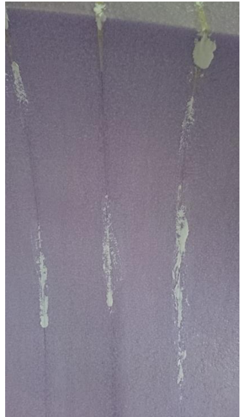
Figur 39 - Tetting av sprekker med leire
