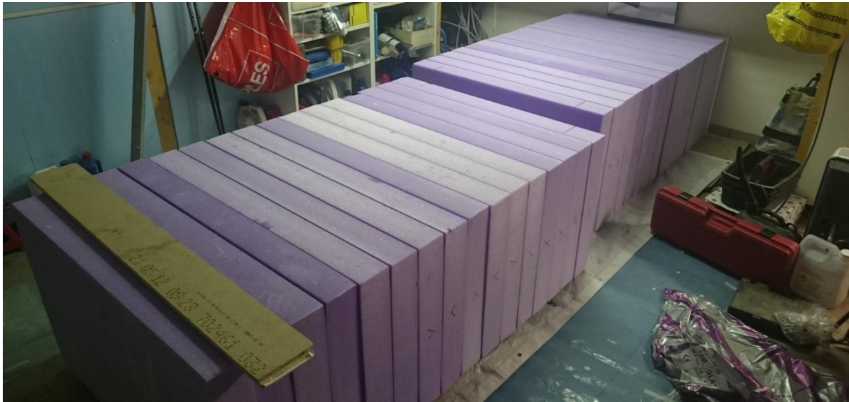
Figur 3 - To polystyrenblokker klare til å limes sammen
