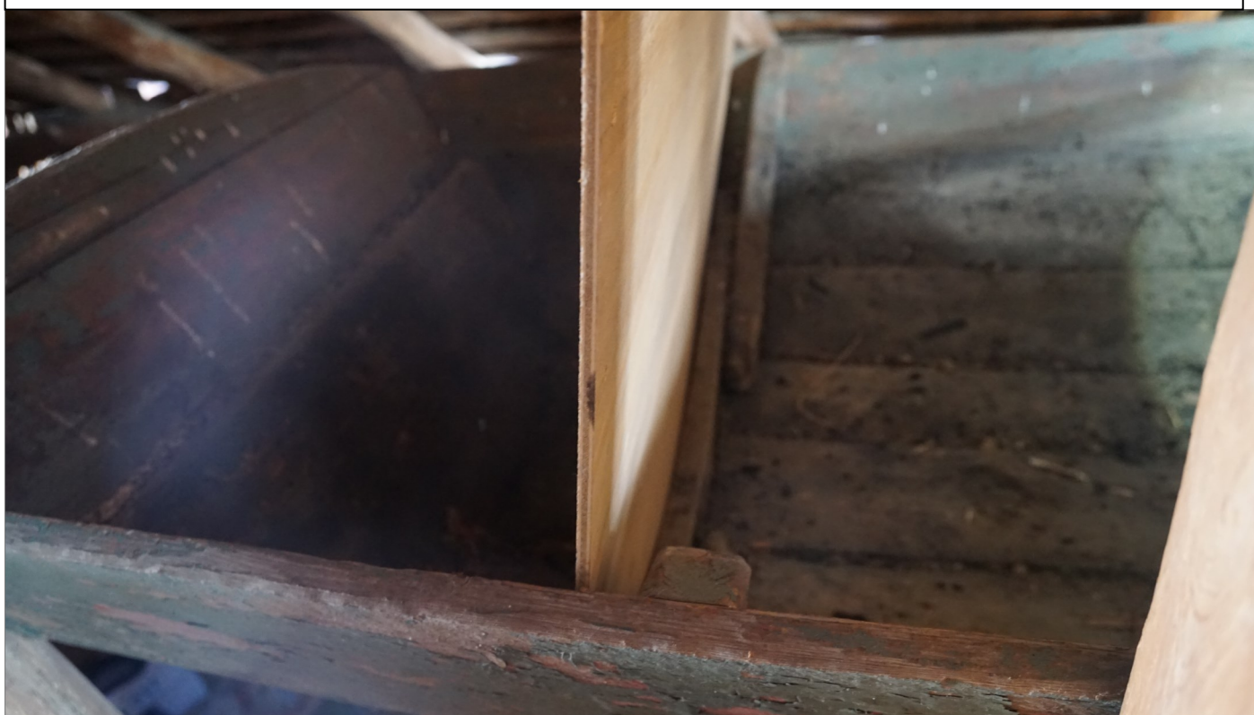
Fig 4. Kryssfinerplater eller tynne bord ble felt på plass på utvalgte målepunkter. Det var naturlig å plassere disse målepunktene i nær tilknytning til banda.
