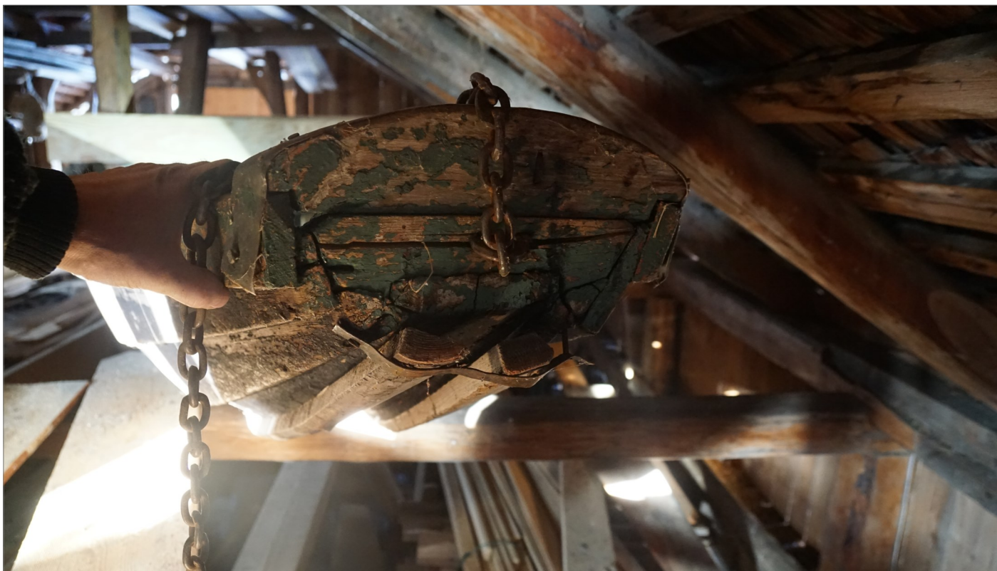
Fig 11. I underkant av prammen, på sua mellom prambordet og den første bordgangen var det lagt slitelister. Det var gjort flere reparasjoner med stålband og plater.
