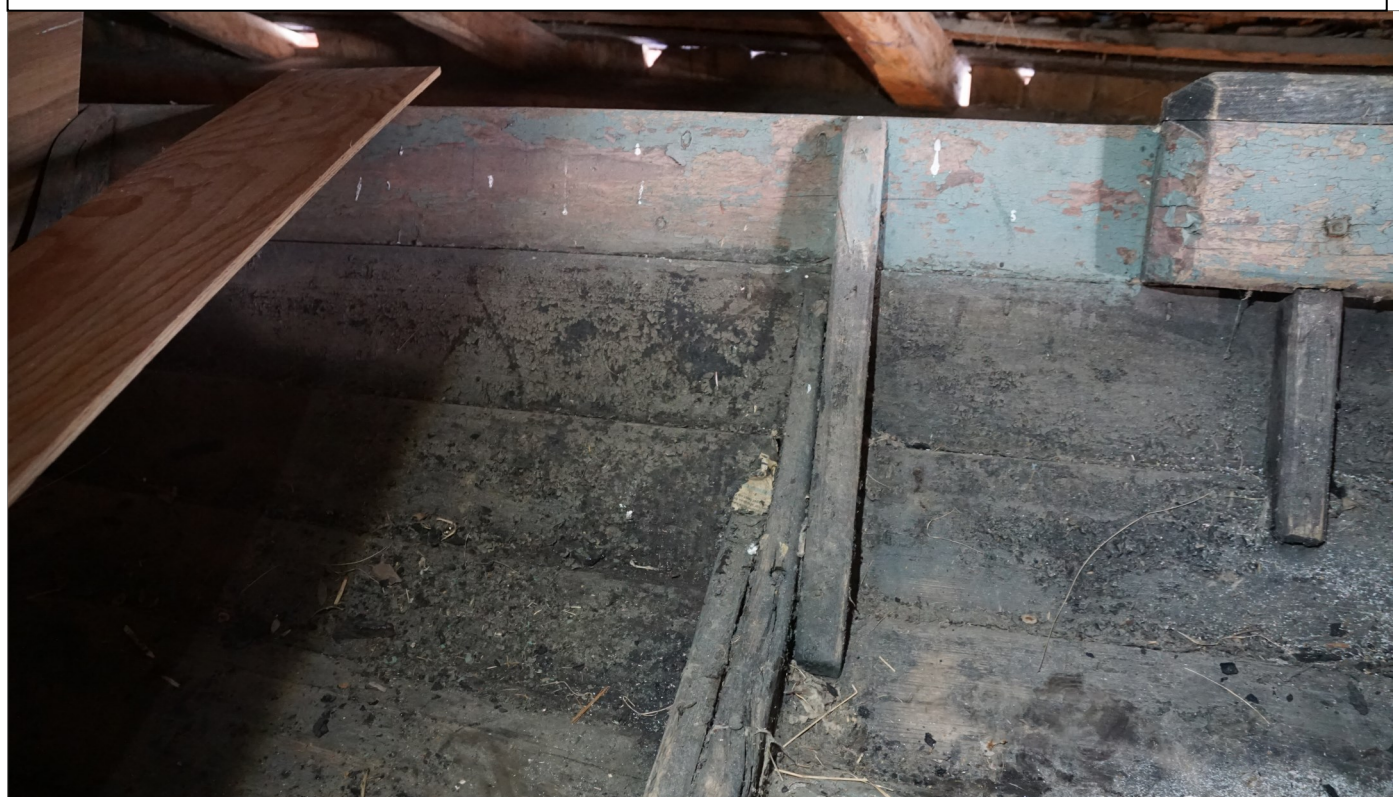
Fig 16. Banda var festet med trenagler og årrettet. Reparasjoner var gjort med spiker. På det andre bandet slik som her var bandemnet nyttet til det fulle og endte i tynn og smal spiss.
