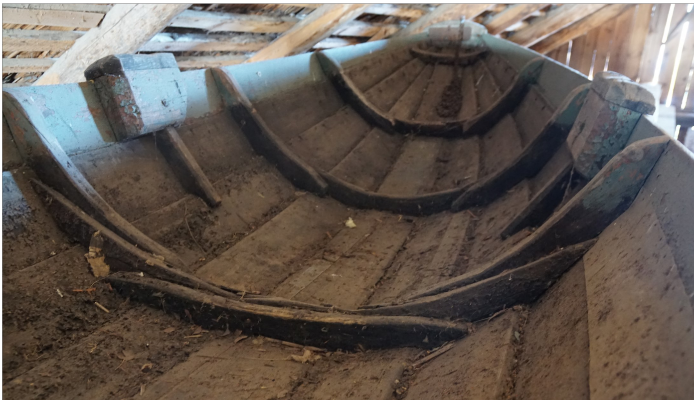
Fig 9. Fremover i prammen. Reparasjonen av band 2 sett frå andre siden. Prammen har 5 band. Hverken band eller bord er like fra side til side. Som hovedtrekk når banda opp på 3 bordgang. Bordganges bredder kan variere med 3 cm på hver side av prambordet.
