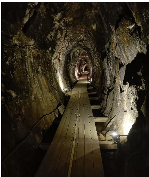
BILETE 3: BILETET VISER VASSKANALEN I PUBLIKUMSRUTA. DET AVRUNDA TAKET VISER AT DET HAR VORE BRUKA FYRSETJING HER.
